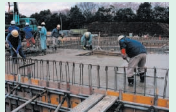
建築物にも使用されます(鉄筋コンクリートへの利用)
