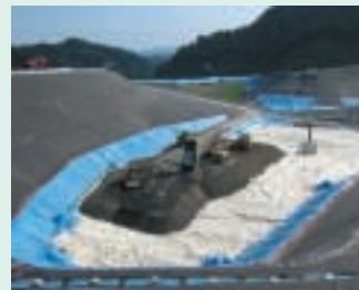
2期エリアへの埋立が始まりました。
