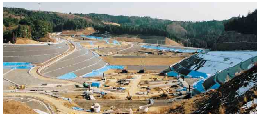
●仕上げ段階に入った第II期工事区域(平成15年2月撮影)
