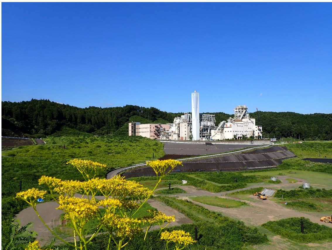
ニツ塚処分場とエコセメント化施設
