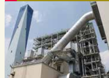
前処理及び焼成時に発生するガスは排ガス処理をして煙突から排出されます。（※焼成で発生した排ガスは、200℃以下に急冷することでダイオキシン類の再合成を防ぎます。また、ばい煙はバグフィルター等の公害防止設備により取り除かれます。）
