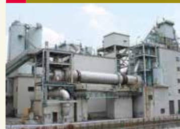
焼却灰を乾燥、粉碎して石灰等の副資材を混ぜます。
