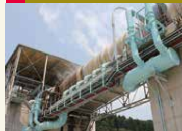
キルン内では1350℃以上の高温で焼き、ダイオキシン類を分解し、クリンカ（塊）をつくります
