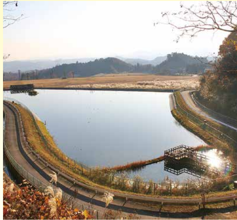
清流復活用貯水池
