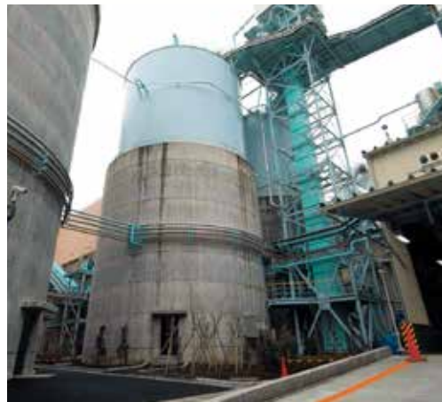
④ エコセメント貯留タンク
