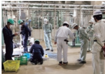
環境調査立会いの様子
