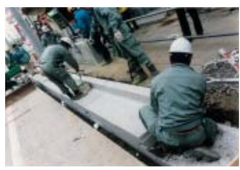
エコセメントは道路の側溝など、土木・建築工事に利用されます。
