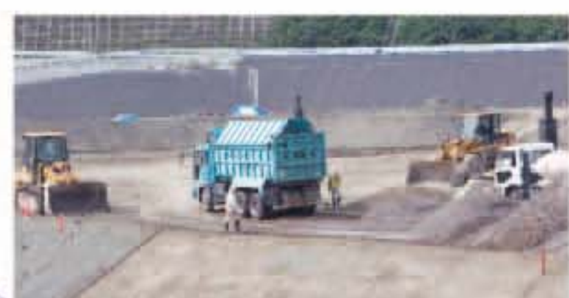
二ツ塚処分場の埋立の様子。
