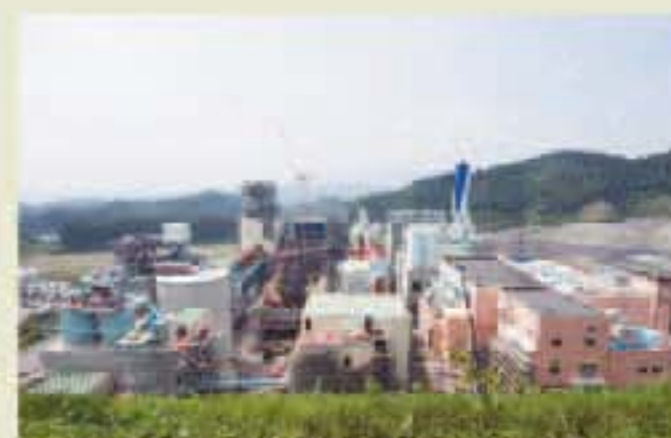
建設中のエコセメント化施設(平成17年9月撮影)。
