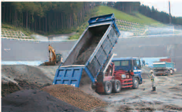
二ツ塚処分場のごみ焼却灰埋立の様子(平成16年9月撮影)。
