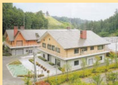
[周辺の自然環境と調和した外観の浸出水処理施設]
