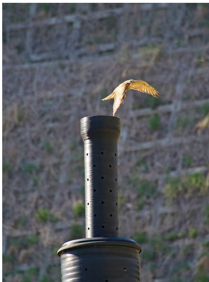
ガス抜き管からの飛翔
